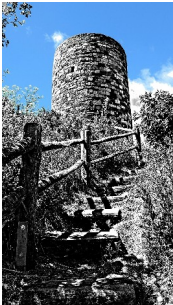
Treppe zur Ruine
